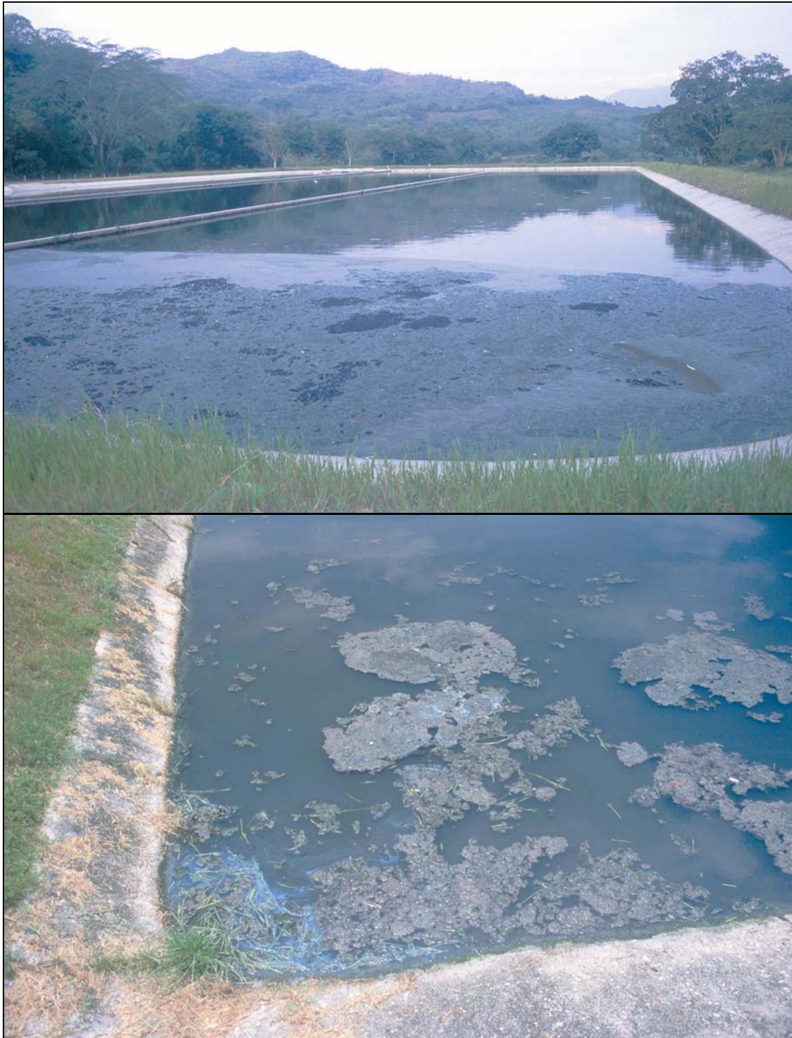
Fotos 7-3: Las natas y los sólidos flotantes usualmente se acumulan en las esquinas de las lagunas, principalmente llevados por el viento. El operador necesita de un desnatador y una carretilla para la limpieza de dichos sólidos. Si no los saca con frecuencia, las natas causarán malos olores debido a descomposición, y además servirán como un lugar adecuado para la reproducción de insectos. (Arriba: Trinidad, Honduras. Abajo: Villanueva, Honduras)
