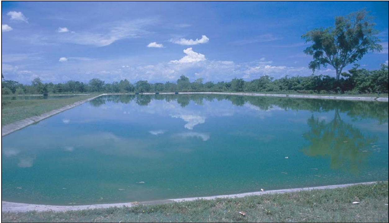
Foto 4-4: Otro ejemplo de una laguna facultativa que está en buen funcionamiento. (Choloma, Honduras)
