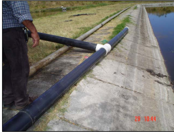
Figura 12 – Cabezal de succión para bombeo de lodos acuosos
