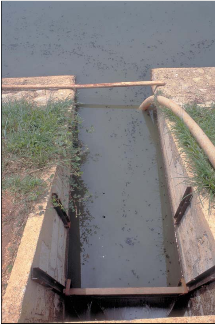
Fotos 7-6: En la foto a la izquierda, la salida de una laguna facultativa diseñada con una compuerta de fondo y un vertedero rectangular no tenía la compuerta y como resultado, los sólidos flotantes estaban saliendo con el efluente y la eficiencia de remoción de DBO_5 y coliformes fecales estaba baja (Catacamas, Honduras). La foto a la derecha muestra una pantalla circular utilizado para controlar la salida de natas en el efluente de una laguna facultativa (Chinandega, Nicaragua)
