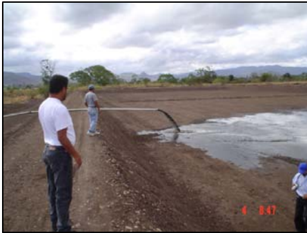
Figuras 15 – Lodos acuosos depositándose en la laguna de secado
