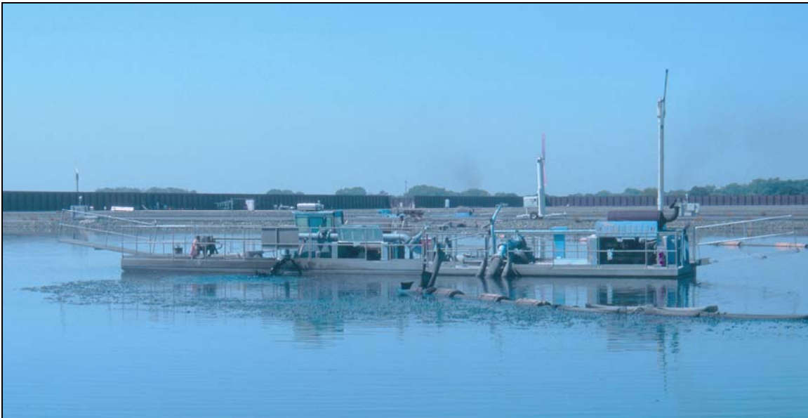
Fotos 8-6: Otros métodos de remover lodos de lagunas primarias incluyen bombeo con camiones de vacío, los cuales son típicamente utilizados para la limpieza del alcantarillado en ciudades grandes, y dragas flotando en una balsa (foto abajo). Los dos métodos requieren la construcción de lechos de secados para los lodos y manejo de lixiviados. (Foto arriba: León, Nicaragua; abajo: Ciudad de Sacramento, California)
