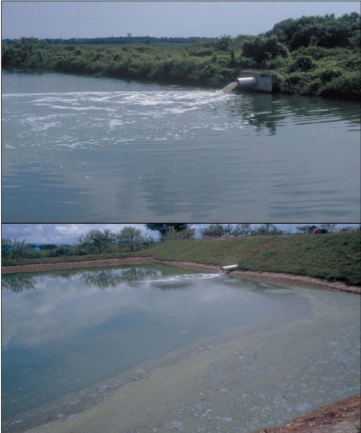
Fotos 6-8: Dispositivos de entrada con una simple entrada arriba de la superficie causan zonas muertas en las esquinas y turbulencia por la caída de agua que no promueve flujo de tipo pistón. Como resultado, las lagunas tienen cortos circuitos hidráulicos, lo que disminuye el volumen útil de la laguna y, entonces, su eficiencia de funcionamiento. Se debe diseñar dispositivos múltiples de entrada y salida en lagunas facultativas y dispositivos sencillos con mamparas desviadoras en lagunas de maduración. (Foto arriba: Choluteca, Honduras. Foto abajo: Catacamas, Honduras)
