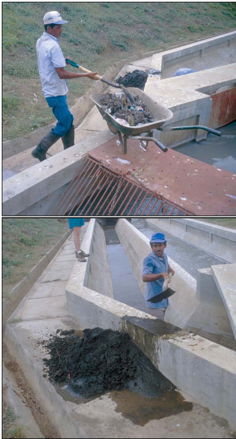
Fotos 7-1: La responsabilidad del operador es limpiar la rejilla diariamente y el desarenador cuando sea necesario—típicamente una vez por semana. Sin embargo, es fundamental agitar los sólidos en el desarenador diariamente para que salgan los sólidos orgánicos a la laguna primaria y para que queden los sólidos inorgánicos en el desarenador. Los sólidos gruesos de la rejilla y los sólidos arenosos del desarenador deben ser enterrados y cubiertos. (León, Nicaragua)
