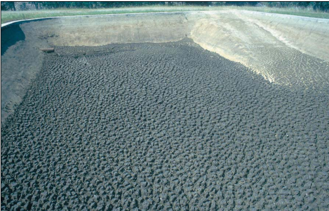
Foto 8-3: Un buen ejemplo de una laguna primaria con los lodos secos después de ser esparcidos y volteados periódicamente para facilitar el secado. Nótese la rampa para el acceso de equipo pesado. (Oroville, California, EE.UU.)
