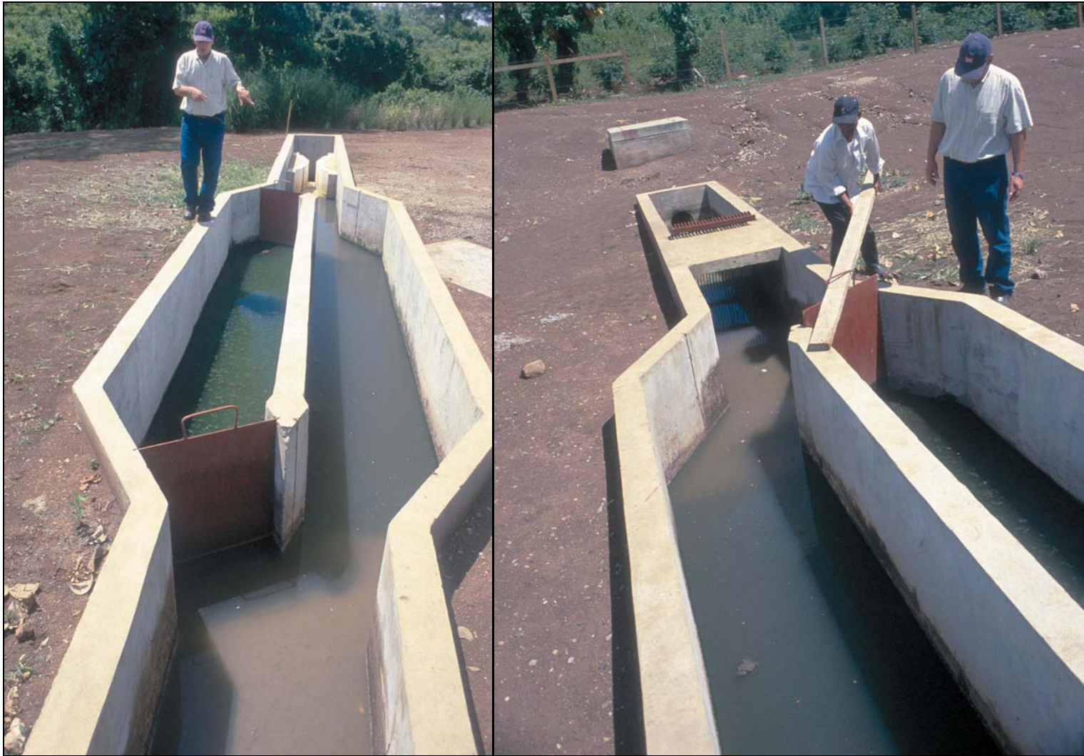
Fotos 6-6: Este desarenador no tenía drenaje y la cámara fuera de servicio (lado izquierdo) estaba llena con agua estancada con problemas de natas flotantes, malos olores, y insectos. El operador tenía que abrir la compuerta y utilizar el desarenador con las dos cámaras en servicio—una operación en lo que no fue diseñado. Todos los desarenadores deben tener drenaje y compuertas que sellan bien. (Santa Cruz de Yojoa, Honduras)
