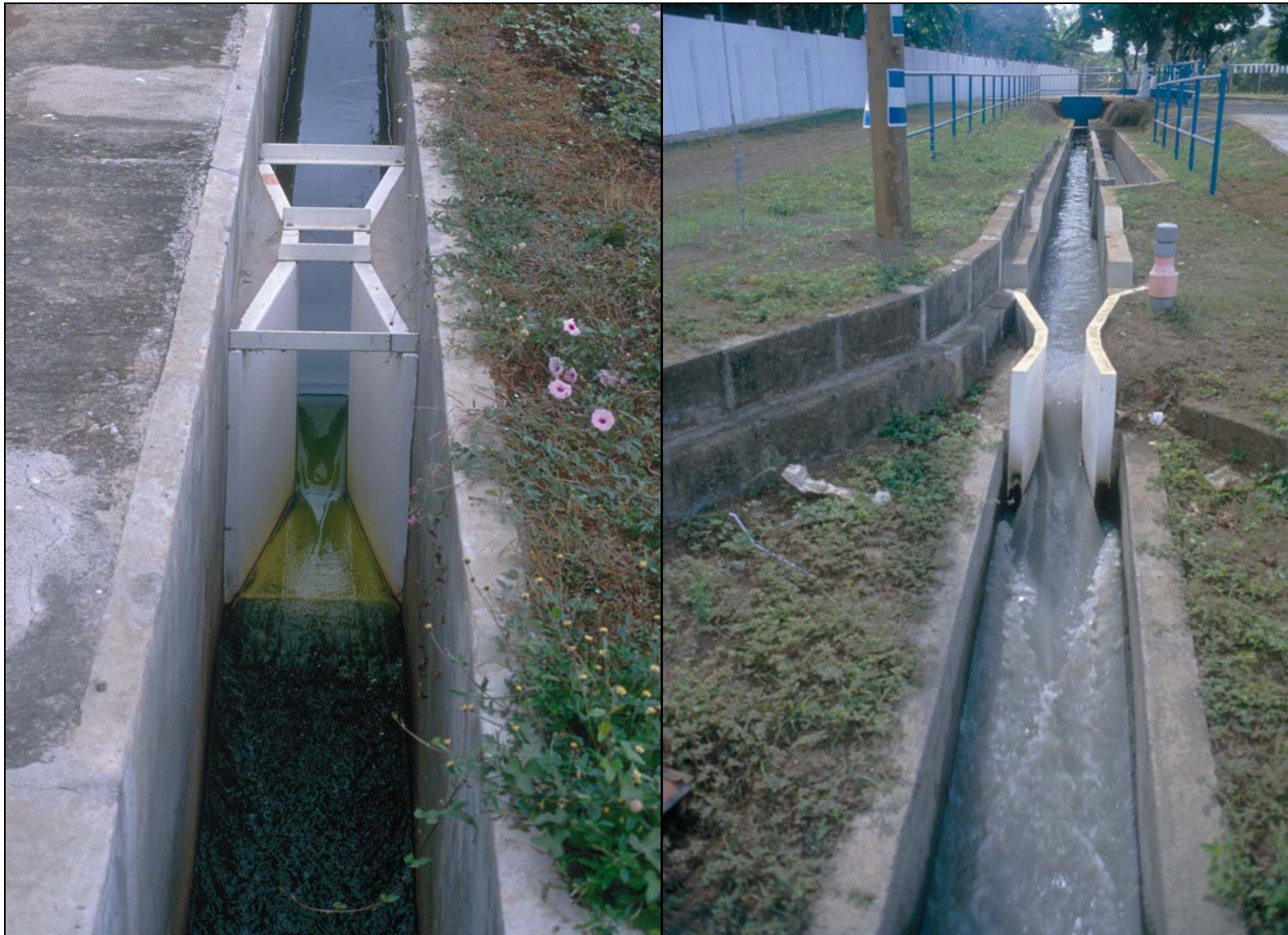
Fotos 3-11: Ejemplos de canaletas Parshall prefabricadas con flujo libre. Para tener flujo libre, el canal aguas abajo la canaleta Parshall tiene que tener suficiente pendiente para que su carga máxima sea \leq 0.60 la carga máxima en el canal del desarenador medida con referencia a la base de canaleta Parshall. (Foto izquierda: León, Nicaragua; derecha: Masaya, Nicaragua)
