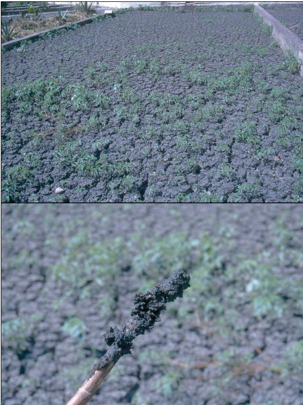
Fotos 8-1: Cuando los lodos empiezan a secar la capa superficial forma una capa dura que previene el secado de las capas inferiores como se ve en estas fotos de un lecho de secado. Mientras la capa superficial está seca (foto arriba), las capas inferiores mantienen su humedad como se ve después de meter un palo por adentro (foto abajo). (Ciudad de Guatemala)
