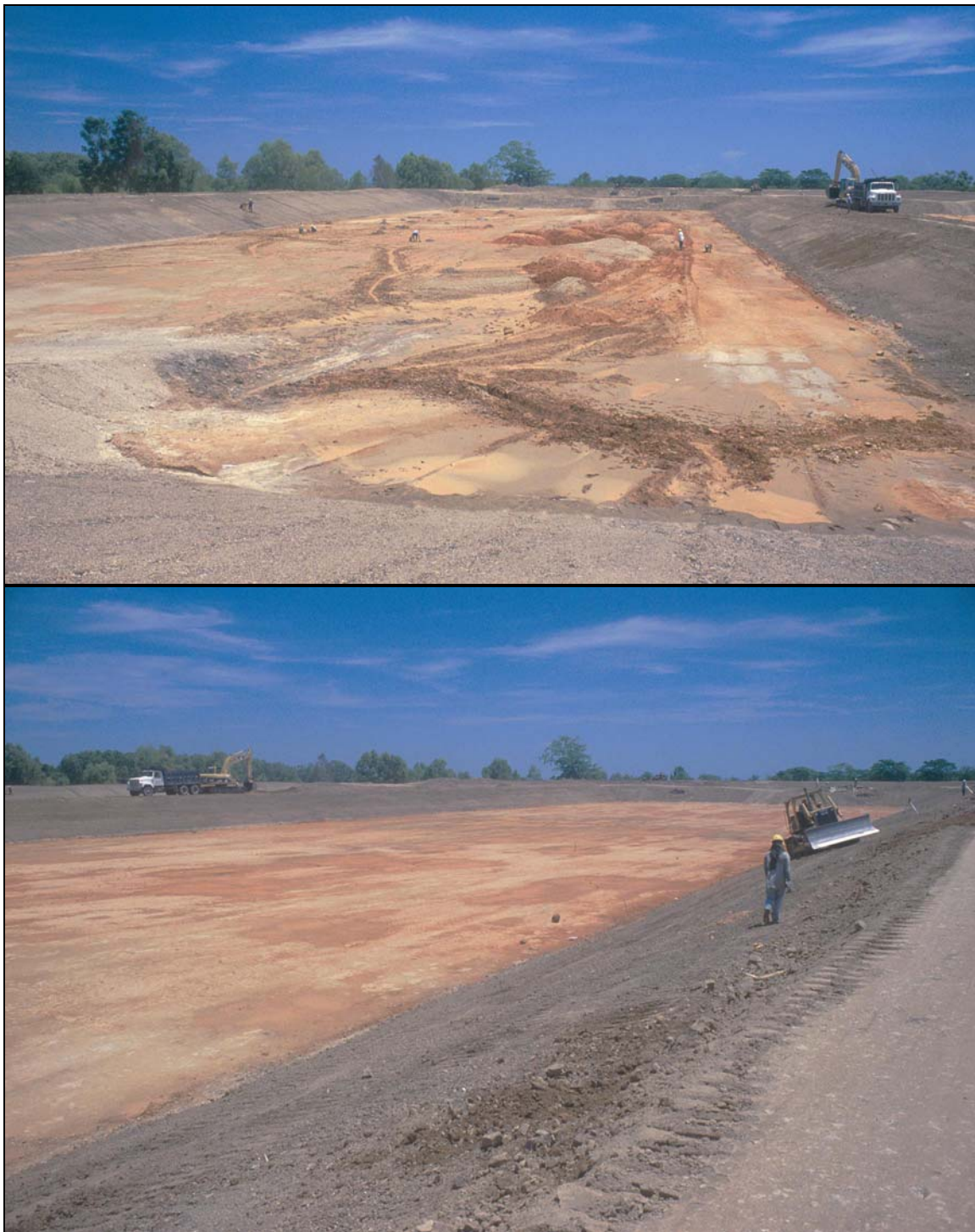
Fotos 6-5: La impermeabilización de lagunas con arcilla es fundamental para poder mantener el balance hídrico y evitar infiltración excesiva con la posible contaminación del agua subterránea. La arcilla debe ser puesta en capas con un espesor total de, por los menos, 5 a 10 cm, y cubierta con una capa de suelo para protegerla. En este ejemplo el contratista no puso arcilla en los taludes interiores y las lagunas tenían infiltración excesiva como se ve en las Fotos 6-4. (La Ceiba, Honduras)
