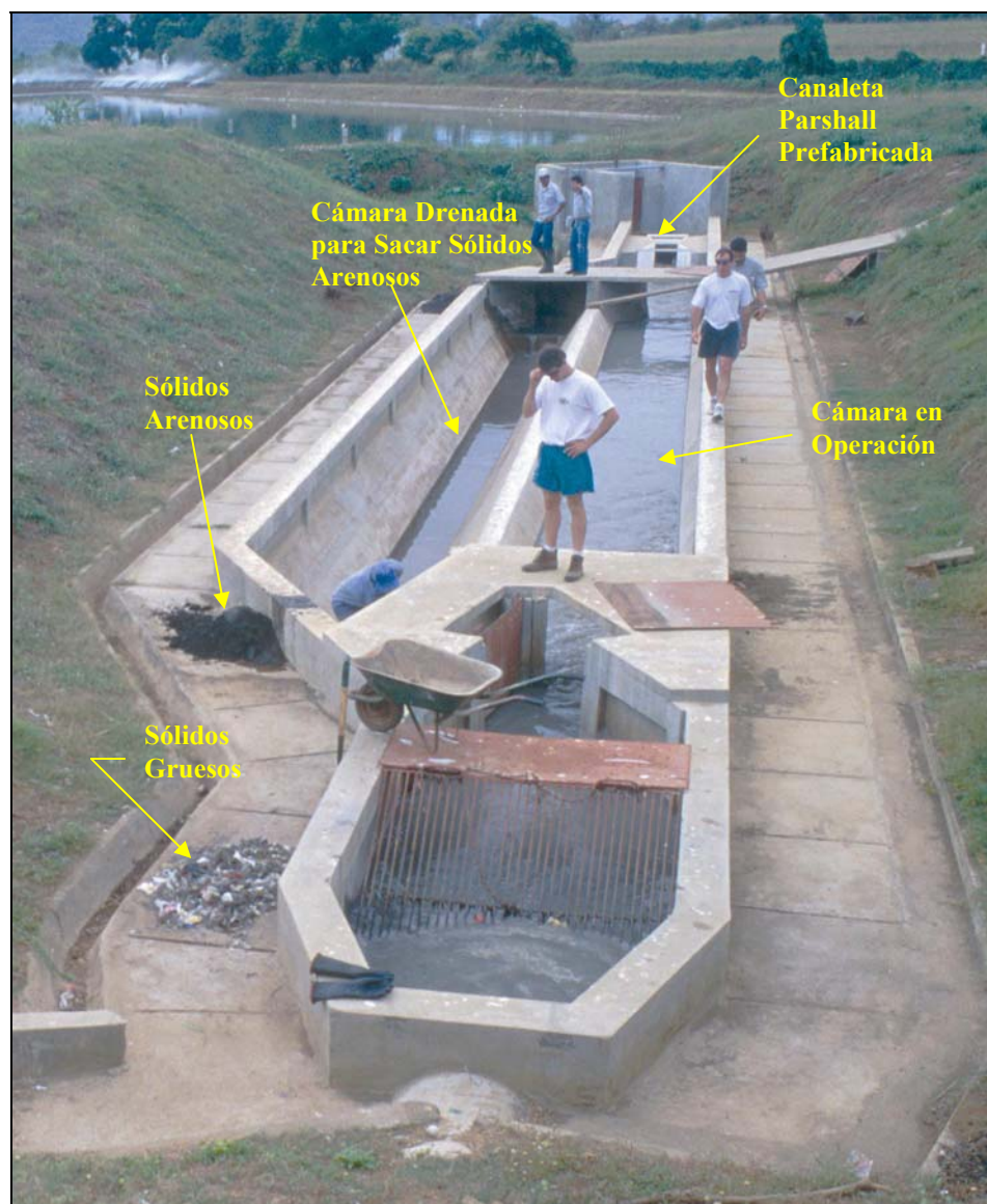
Foto 3-3: Una rejilla y un desarenador diseñados para una laguna facultativa, seguidos por una canaleta Parshall prefabricada para controlar el nivel de agua, la velocidad horizontal en el desarenador, y medir los caudales. Arriba de la rejilla hay una plataforma de drenaje para drenar los sólidos gruesos removidos con un rastro antes de enterrarlos. El desarenador tiene dos cámaras: Se desvía el caudal a una cámara y se drena la otra para sacar los sólidos arenosos. Este desarenador fue instalado porque la carga de arena fue excesiva y la laguna estaba llenando prematuramente con lodos arenosos. Nótese las pilas de los sólidos gruesos y arenosos sacados por el operador y la carretilla utilizada para llevar los sólidos a su lugar de enterramiento. (León, Nicaragua)
