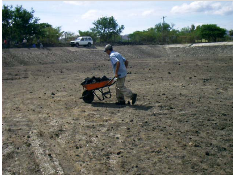
Figura 9 – Retirando lodos con carretilla de la laguna secundaria “A”
