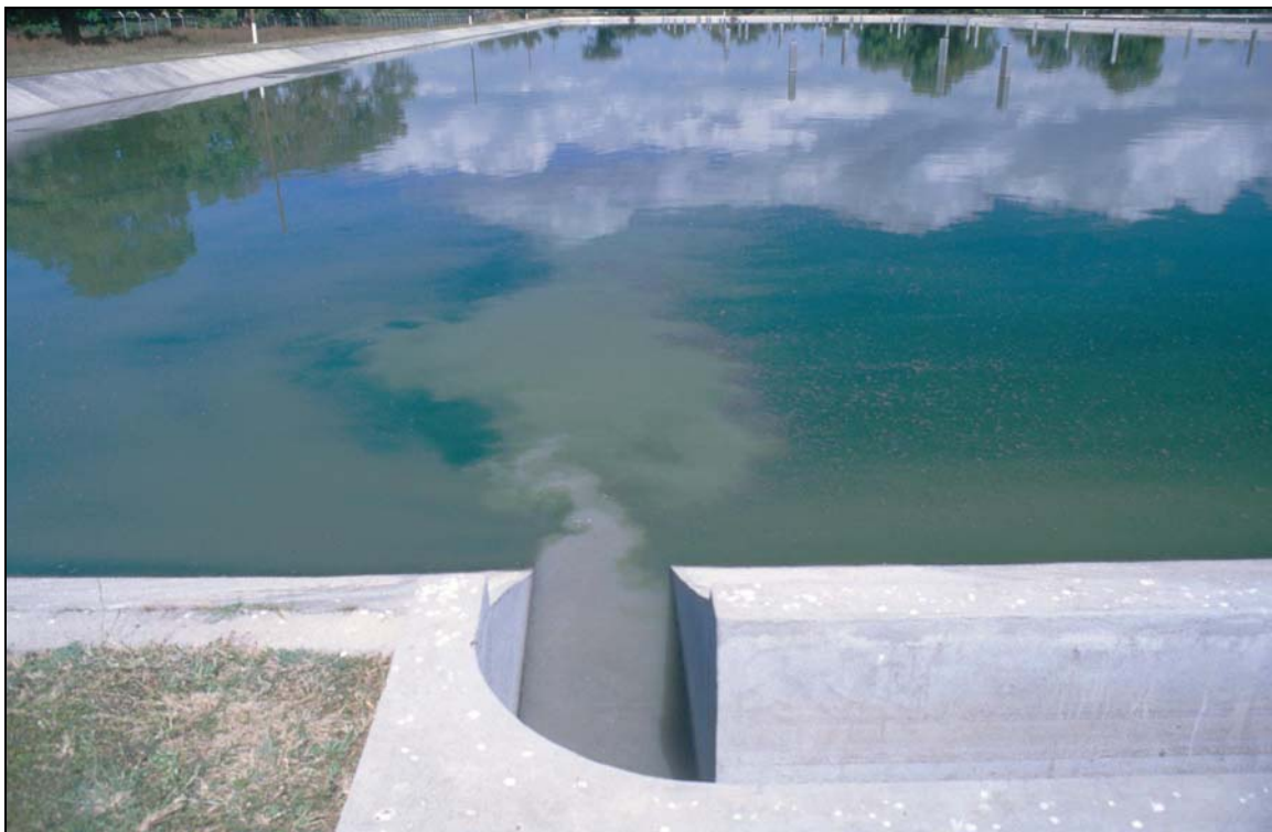
Foto 6-9: Un buen ejemplo de una entrada con el canal abierto que entra la laguna facultativa al nivel de agua. Se ve claramente que la pluma de aguas residuales crudas que entra la laguna está aproximando al flujo de tipo pistón. (Granada, Nicaragua)
