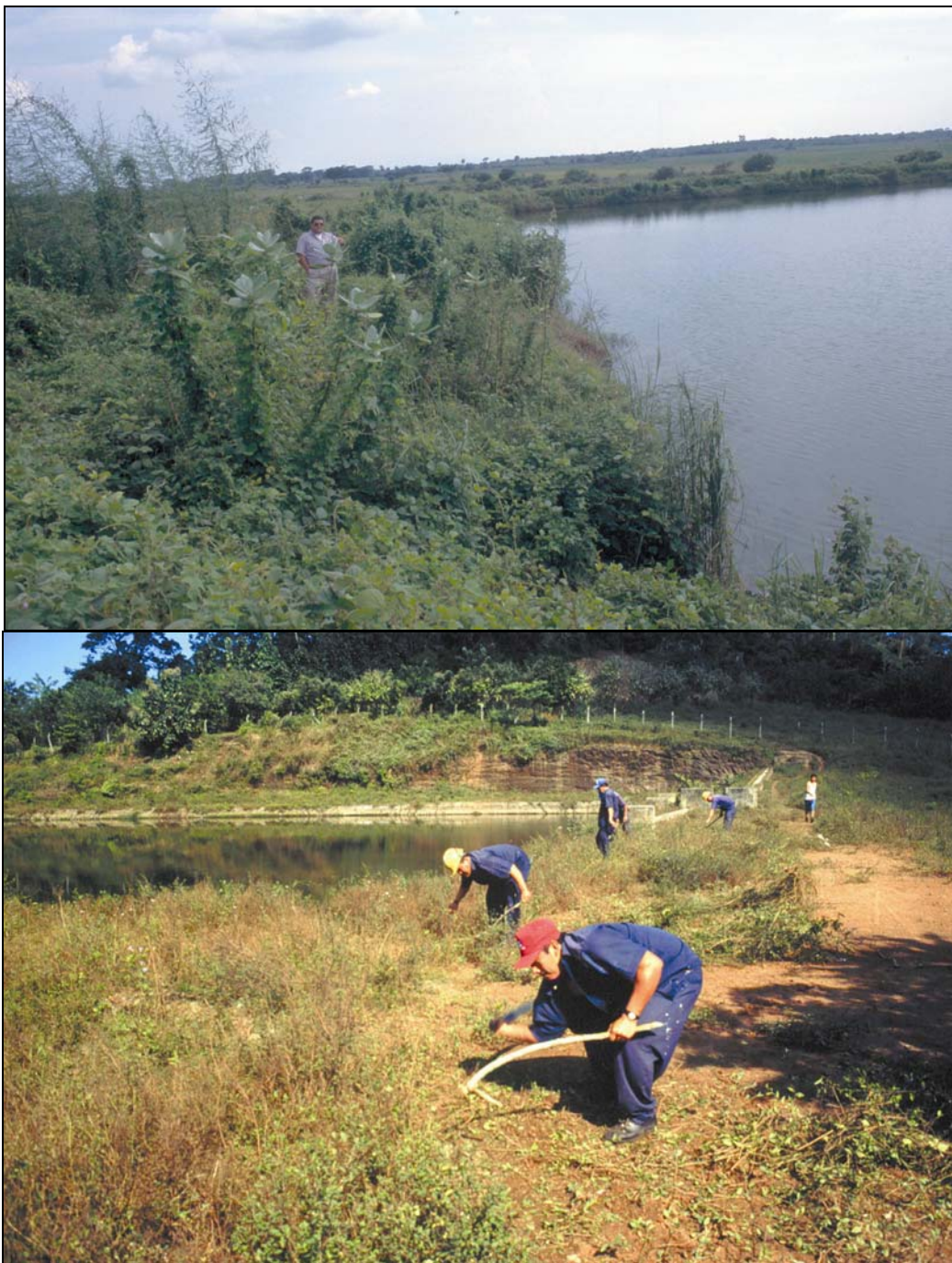
Fotos 7-7: En la foto arriba (Choluteca, Honduras) la laguna facultativa tiene problemas serios con el sobre-crecimiento de la maleza en la corona del terraplén y en la orilla. (Nótese el hombre en el centro de la foto.) Es un trabajo fundamental del operador a controlar el crecimiento de la maleza como se ve en la foto abajo donde una brigada de personal de la Administración Nacional de Agua y Alcantarillado (ANDA) de El Salvador corta las malezas en el terraplén de la laguna facultativa (Zaragoza, El Salvador)
