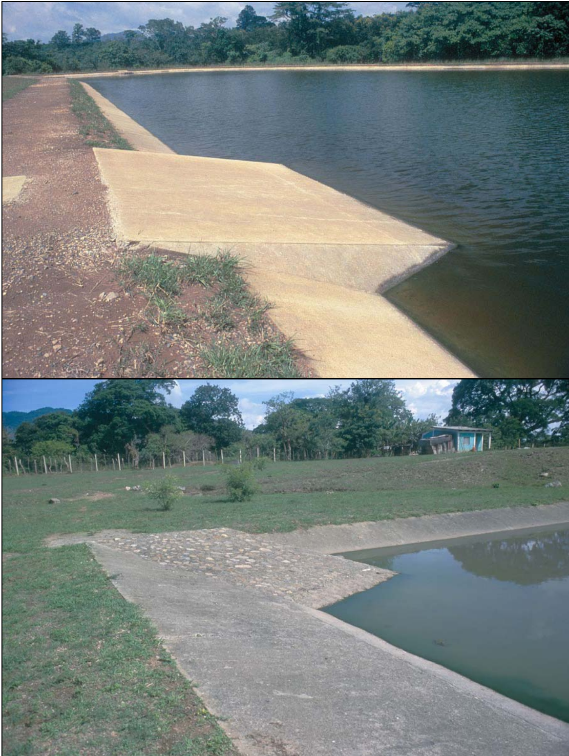
Fotos 6-20: Ejemplos de rampas de acceso en lagunas primarias para la remoción de lodos. (Foto arriba: laguna facultativa de Santa Cruz de Yojoa, Honduras; Foto abajo: Laguna anaeróbica de Danlí, Honduras)
