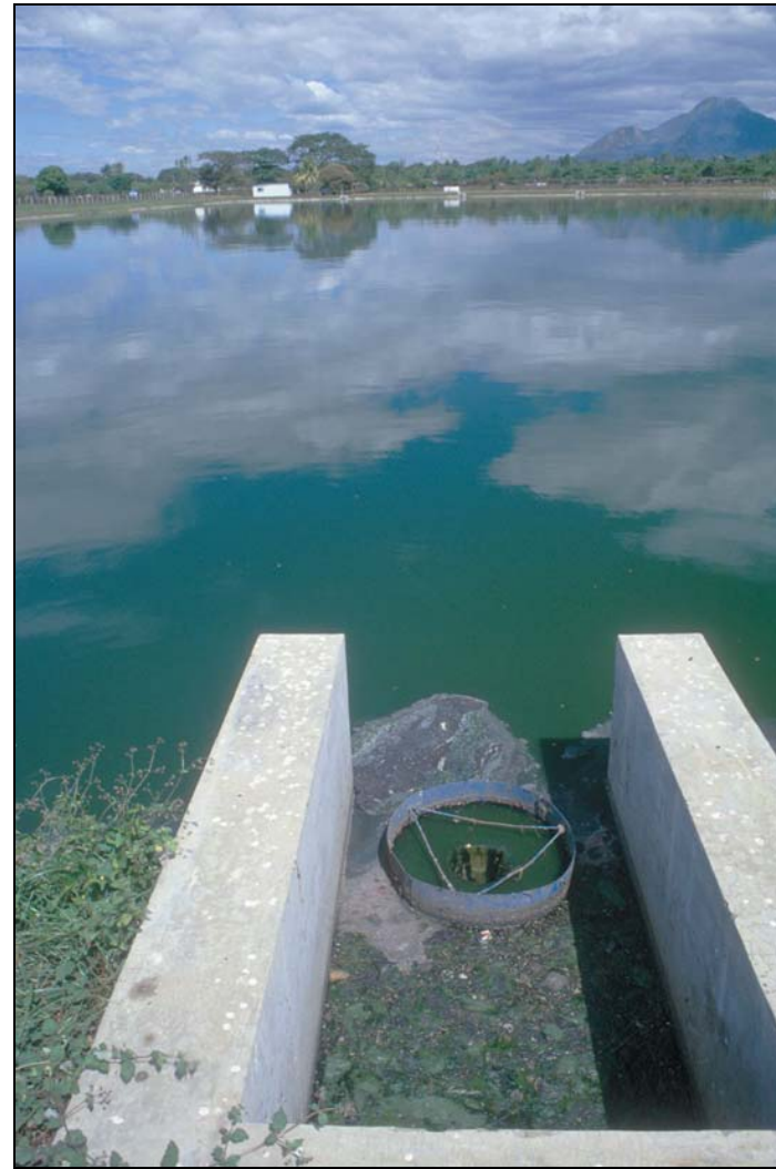
Fotos 7-6: En la foto a la izquierda, la salida de una laguna facultativa diseñada con una compuerta de fondo y un vertedero rectangular no tenía la compuerta y como resultado, los sólidos flotantes estaban saliendo con el efluente y la eficiencia de remoción de DBO_5 y coliformes fecales estaba baja (Catacamas, Honduras). La foto a la derecha muestra una pantalla circular utilizado para controlar la salida de natas en el efluente de una laguna facultativa (Chinandega, Nicaragua)
