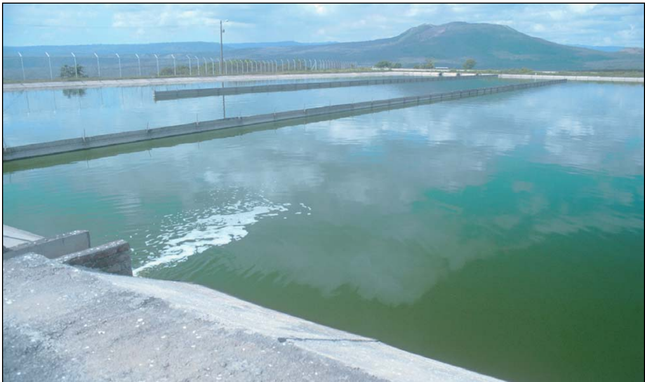
Foto 4-5: Un ejemplo de una laguna de maduración canalizada con mamparas para modelar flujo de tipo pistón. Las lagunas de maduración deben tener una relación de largo/ancho mínima de 20 a 1, y preferiblemente 50 a 1. (Masaya, Nicaragua)
