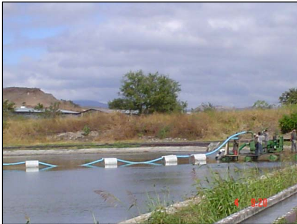
Figuras 13 –Manguera de impulsión sobre el agua
