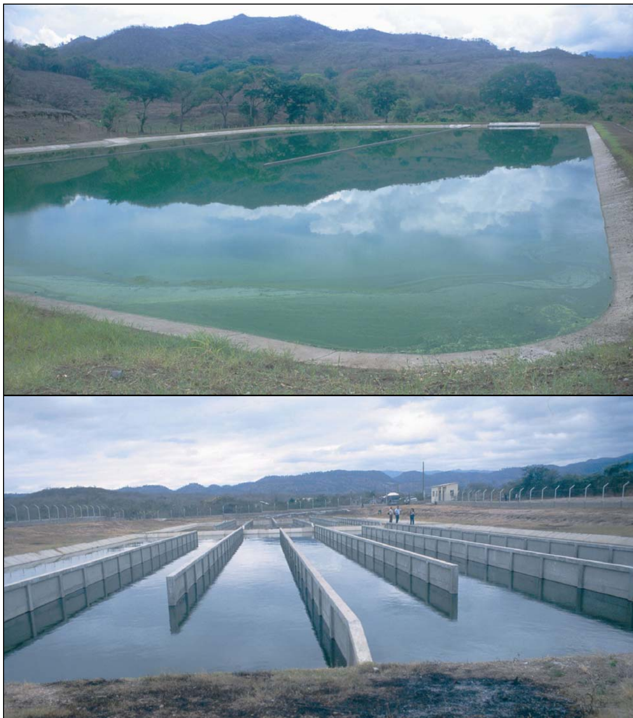
Fotos 4-6: Otros ejemplos de lagunas de maduración que están canalizadas con mamparas. En la foto arriba la relación largo/ancho aproxima 20/1, y en la foto abajo 50/1. En la foto abajo las mamparas están demasiado arriba del nivel del agua y prohíben la insolación solar por la sombra que forman; deben estar más por abajo como en la foto arriba. (Foto arriba: Trinidad, Honduras; abajo: Morocelí, Honduras)
