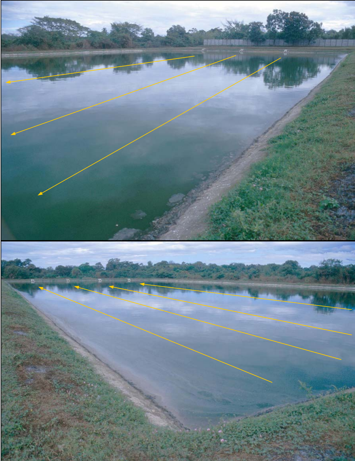
Fotos 6-10: Se utiliza entradas (foto arriba) y salidas (foto abajo) múltiples en lagunas facultativas para aproximarse al flujo de tipo pistón. No debe utilizarse mamparas desviadoras en las facultativas porque ellas requieren el aprovechamiento máximo del área para recibir la insolación solar; también los dispositivos múltiples promueven la distribución uniforme de lodos depositados. (Chinendega, Nicaragua)
