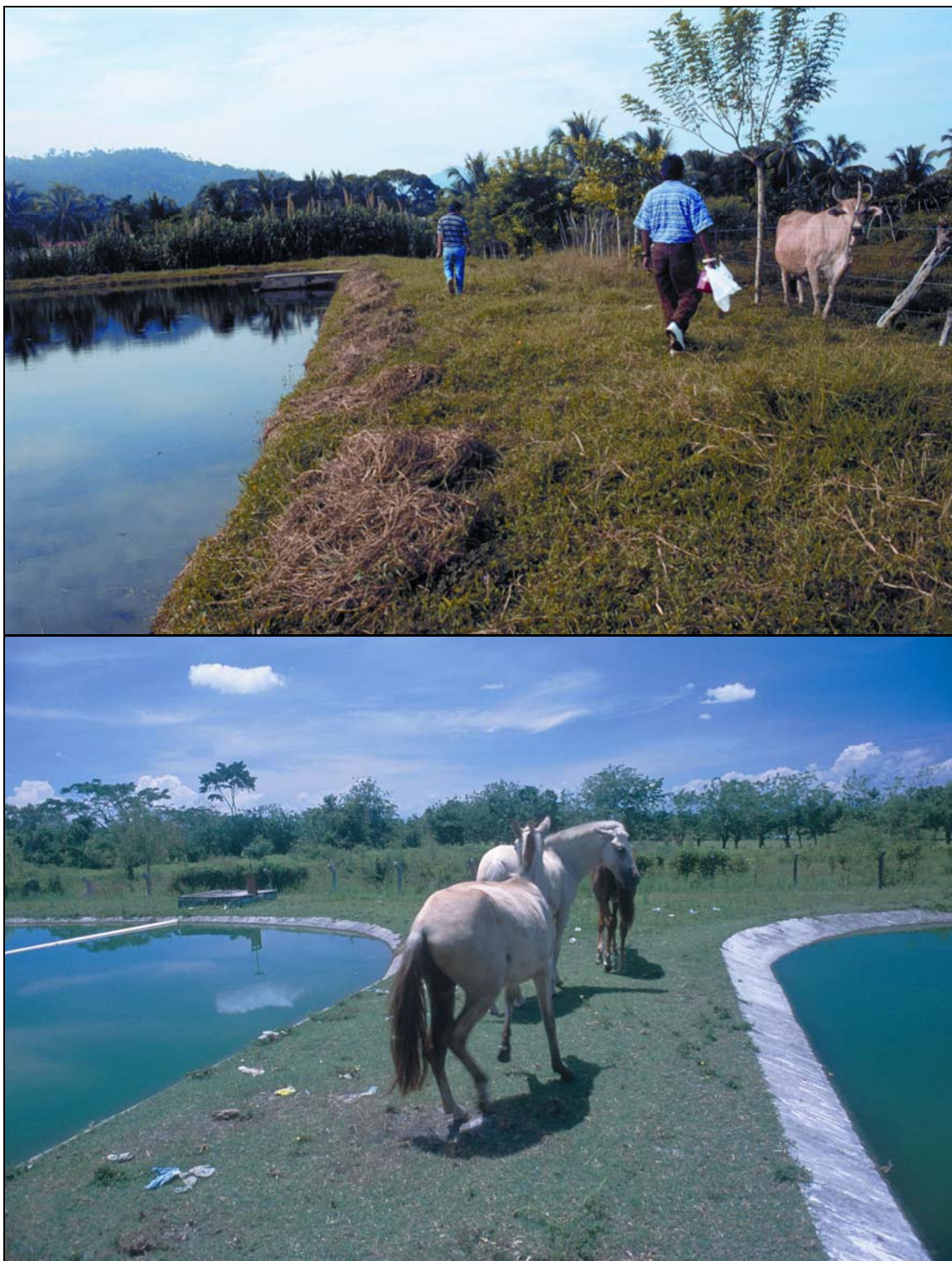
Fotos 6-21: El área que comprende la instalación de lagunas debe estar cercado, preferiblemente con alambre de púas, para prevenir la entrada de animales, que pueden dañar los taludes y servir como focos infecciosos, y la de personas no autorizadas. (Foto arriba: Tela, Honduras; Foto abajo: Choloma, Honduras)
