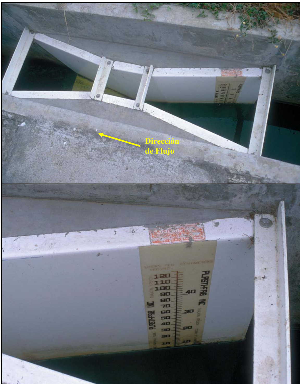
Fotos 3-10: Un ejemplo de una canaleta Parshall prefabricada instalada en un sistema de lagunas. El diseñador siempre debe requerir canaletas Parshall prefabricadas en el diseño y nunca canaletas Parshall hechas de concreto por los problemas de construcción y calibración como se muestran en las Fotos 3-12 y 3-13 adelante. (Masaya, Nicaragua)
