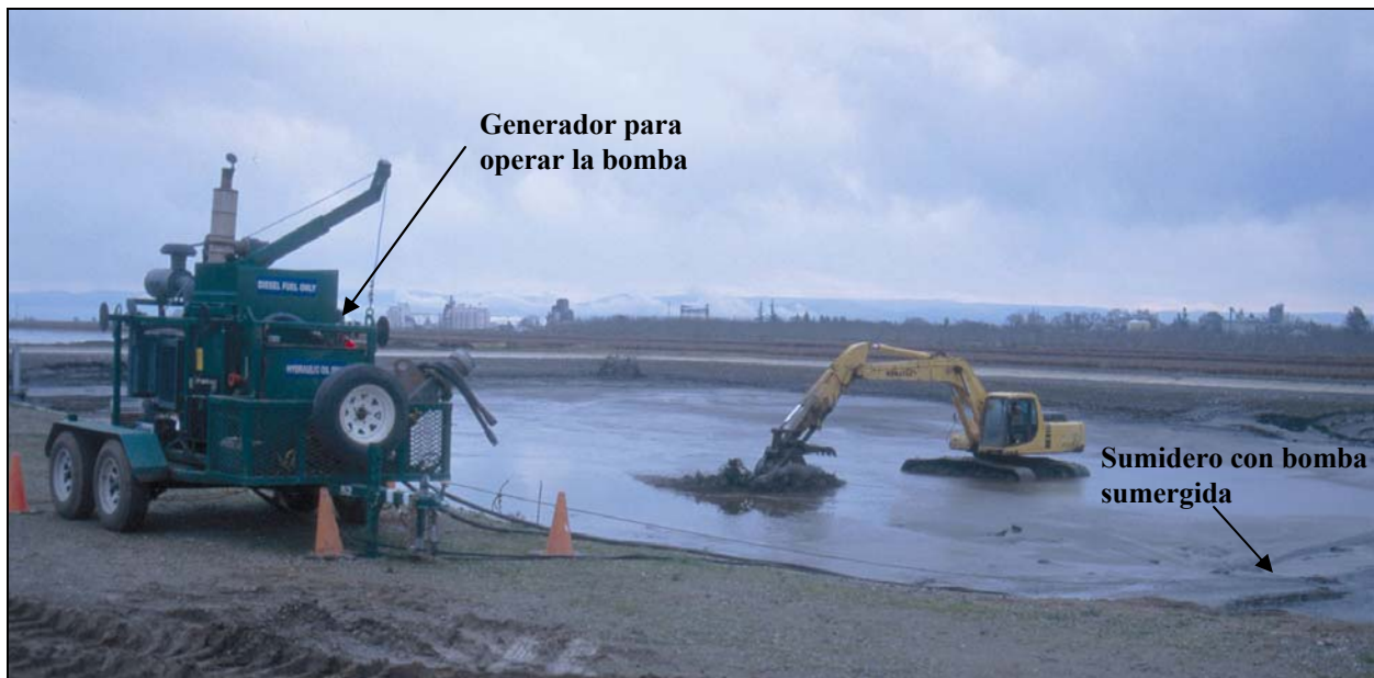
Fotos 8-5a: Un ejemplo del secado parcial con empuje por una excavadora y bombeo con una bomba sumergida de desplazamiento positivo. La bomba fue colocada en un sumidero construido por el contratista y los lodos bombeados a un lecho de secado al lado de laguna primaria (Véase las fotos seguidas). La excavadora solamente está empujando los lodos hacia el pozo de bombeo. (Municipalidad de Biggs, California)
