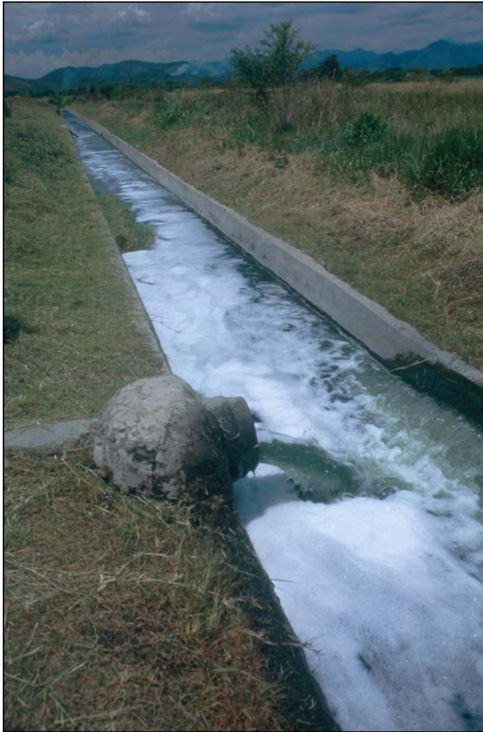
Fotos 6-15: Un ejemplo de la espuma que puede ser formada por la turbulencia cuando la descarga final está arriba del nivel de agua en el cuerpo receptor. La espuma es causada por los detergentes y otros tensoactivos no biodegradables en las aguas residuales. La manera de controlar la producción de espuma es de utilizar dispositivos de descarga abajo el nivel de agua como se presenta en la Figura 6-5. (Villanueva, Honduras)
