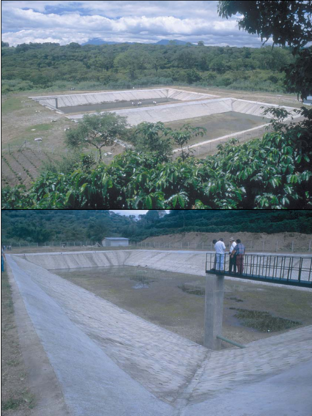
Fotos 4-1: Dos lagunas anaeróbicas en paralelo diseñadas en Boca del Monte, Guatemala. La profundidad de 4 m es típica de lagunas anaeróbicas. El problema fundamental es la dificultad de remover los lodos cuando sea necesario: normalmente, por su profundidad, los lodos tienen que ser removidos mojados por bomba o draga, lo que es mucho más costoso que remoción por secado, como se discute en el Capítulo 8. Notase el dispositivo de drenaje en la foto abajo.
