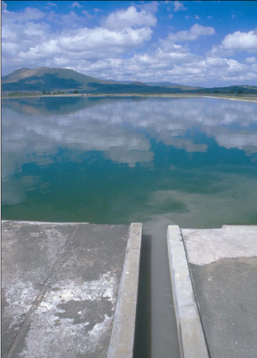
Foto 4-3: Un buen ejemplo de una laguna facultativa bien diseñada y operada. La laguna no tiene malos olores ni crecimiento de plantas acuáticas. El color verde es causado por las algas que producen oxígeno por la fotosíntesis. (Masaya, Nicaragua)
