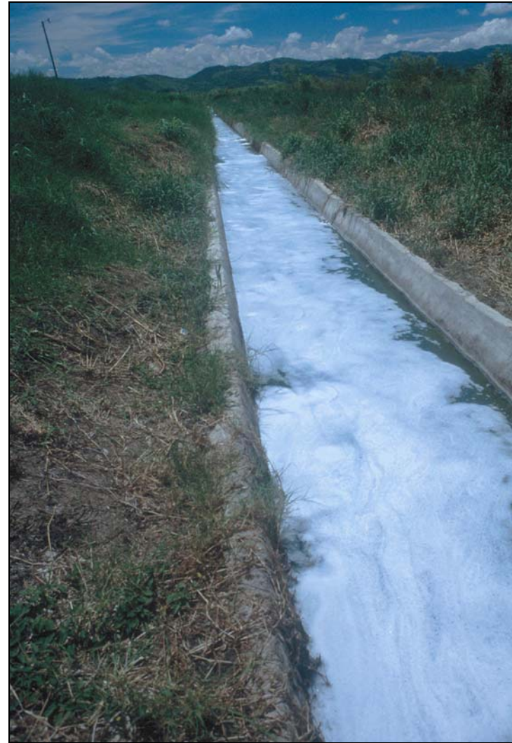
Fotos 6-15: Un ejemplo de la espuma que puede ser formada por la turbulencia cuando la descarga final está arriba del nivel de agua en el cuerpo receptor. La espuma es causada por los detergentes y otros tensoactivos no biodegradables en las aguas residuales. La manera de controlar la producción de espuma es de utilizar dispositivos de descarga abajo el nivel de agua como se presenta en la Figura 6-5. (Villanueva, Honduras)
