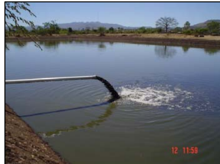
Figuras 15 – Lodos acuosos depositándose en la laguna de secado
