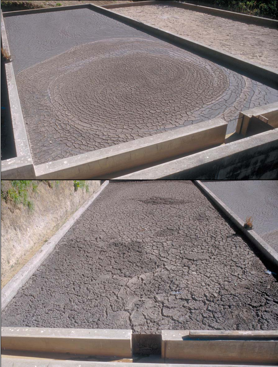
Fotos 8-2: En el lecho de secado arriba los lodos están frescos y acaban de empezar secando con una capa superior duro que impide la evaporación de agua en las capas inferiores. Luego, después de secar más, los lodos empiezan formar grietas, los cuales facilitan el secado de las capas inferiores como se ve en la foto abajo. (San Juan Comalapa, Guatemala)
