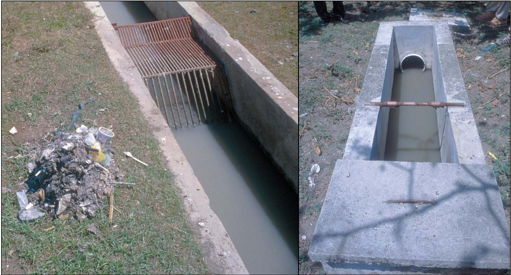
Fotos 3-7: La rejilla a la izquierda, mientras que tiene una abertura apropiada para que retenga los sólidos más gruesos y que permita pasar las heces humanas, y también una plataforma de drenaje adecuada, no debe ser construida de barras de refuerza. Las barras de refuerza, por la calidad de metal utilizada en su construcción, no duran por muchos años en un sistema de aguas residuales donde se favorece las condiciones de corrosión. Los sólidos en la foto izquierda deben ser enterrados inmediatamente para proteger la salud pública. (Izquierda: Granada, Nicaragua; Derecha: Choloma, Honduras)
