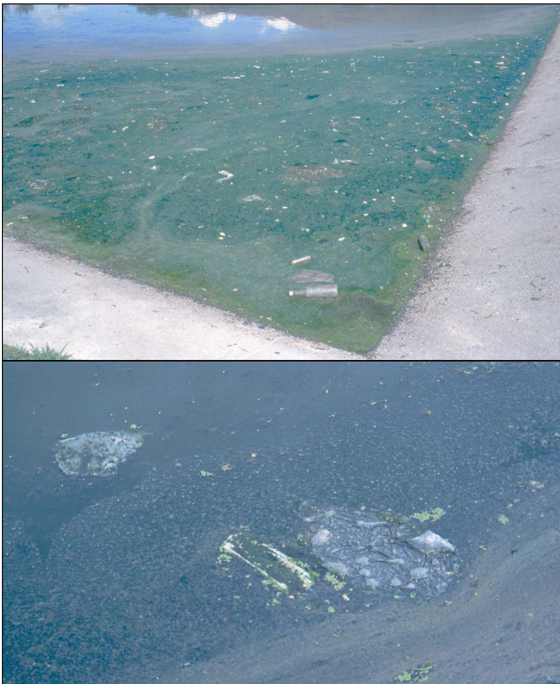
Fotos 3-1: Los sólidos flotantes y gruesos pueden causar problemas nocivos en la operación de las lagunas: ellos ayudan la formación de nata que puede producir malos olores, sirven como un foco para la reproducción de insectos, y producen condiciones desagradables a la vista. Se deben ser removidos a través de rejillas en la entrada del sistema. (Foto arriba: Danlí, Honduras; abajo: Morocelí, Honduras)
