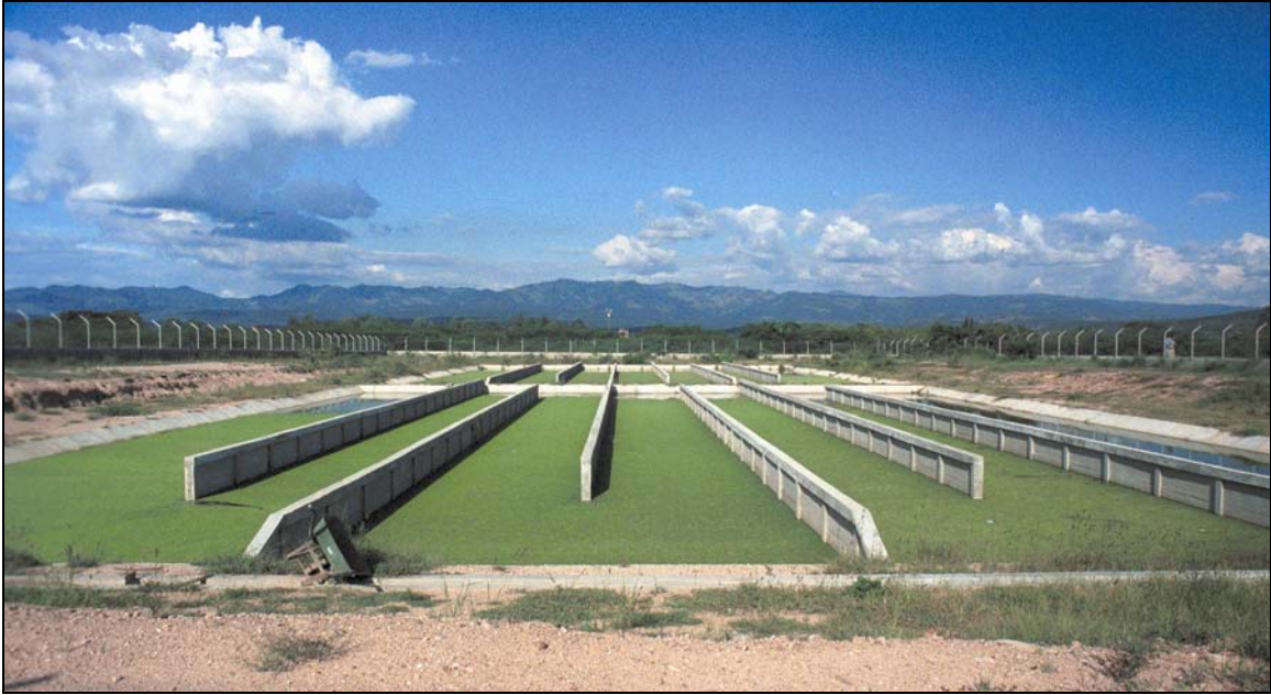
Fotos 7-8: Un ejemplo de lemna, llevado por el viento o por aves, que ha cubierto la superficie de una laguna facultativa. El operador deber sacar la lemna tan pronto como pueda antes de que se cubra la laguna. Hay ejemplos del uso de patos domésticos—la especie se llama pato Pekín—para limpiar la lemna que ha contaminado las lagunas: los patos comen la lemna. (Morocelí, Honduras)
