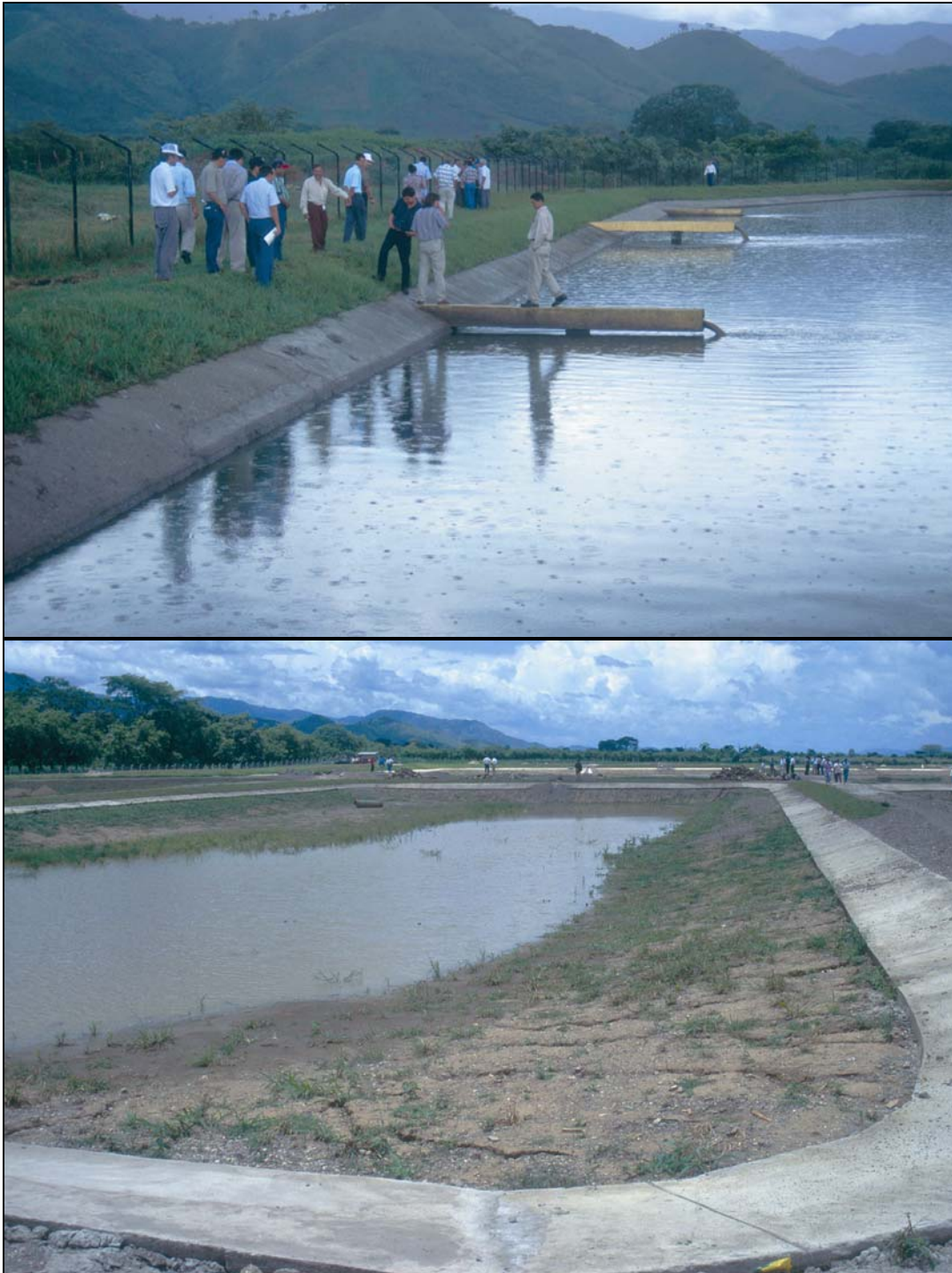
Fotos 6-19: Ejemplos de revestimientos bien contruidos. La foto arriba (Catacamas, Honduras) es el nuevo revestimiento construido para la laguna con el mal revestimiento mostrado en la foto anterior después de una rehabilitación. La foto abajo muestra un revestimiento bien construido para una laguna de maduración (Catacamas, Honduras)
