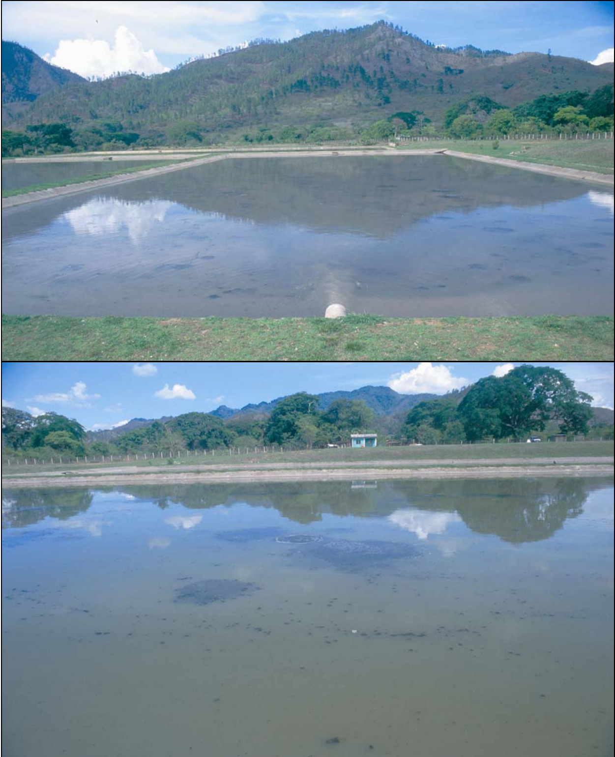
Fotos 4-2: Las lagunas anaeróbicas de Danlí, Honduras. Se ve claramente las burbujas llevando los lodos sedimentados a la superficie (los colores negros), que pueden también llevar los huevos de helmintos a la siguiente laguna. Estas lagunas están llenando con lodos y, por su profundidad, será difícil y costoso removerlos, un problema típico del uso de lagunas anaeróbicas.
