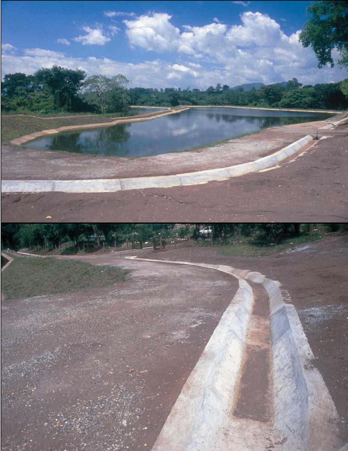
Fotos 6-3: Si la ubicación del sistema de lagunas está aguas abajo del escurrimiento de agua pluvial, se debe utilizar canales para el desvío del escurrimiento para evitar erosión de los taludes interiores (véase la Foto 6-2) y también una carga adicional de sólidos sedimentables llevados por el escurrimiento. (Santa Cruz de Yojoa, Honduras)
