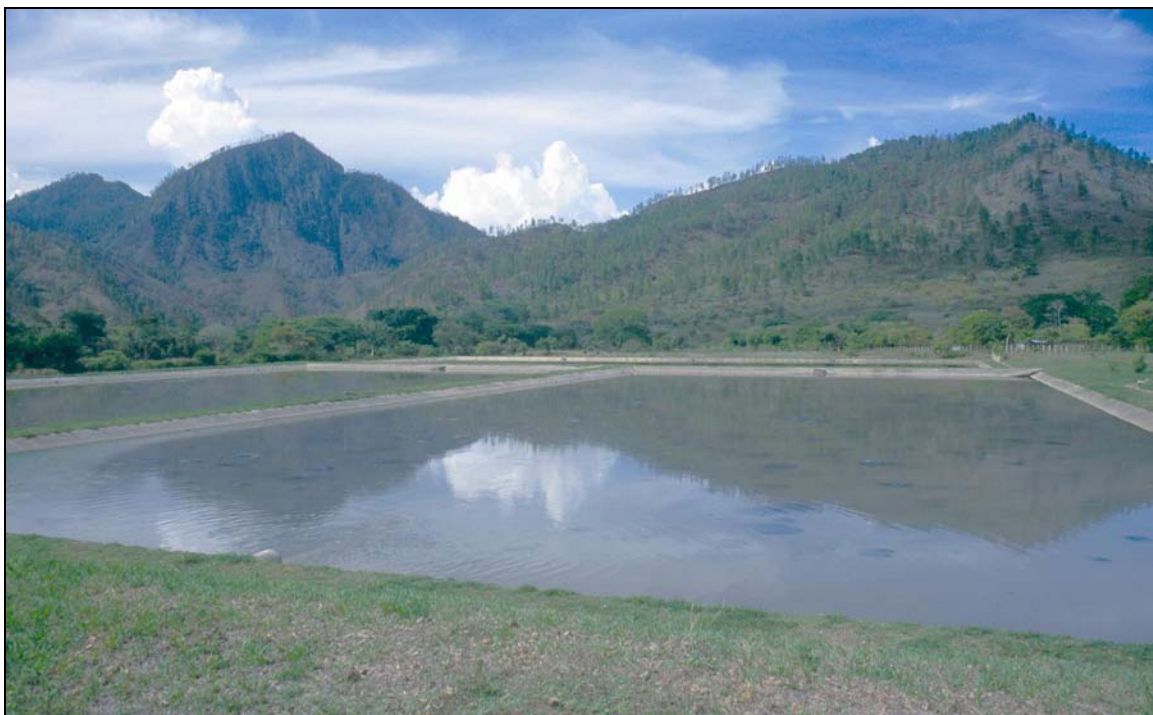
Foto 6-1: Ejemplos de sistemas de lagunas bien diseñadas y mantenidas. Los terraplenes están mantenidos con el corte de hierbas en la orilla. Los taludes interiores tienen un revestimiento de concreto o mortero que sirve para controlar el crecimiento de plantas acuáticas y evitar la erosión por acción de olas. La superficie del agua no tiene materiales flotantes ni natas, y el nivel del agua está mantenido en el centro del revestimiento. (Foto arriba: Villanueva, Honduras. Foto abajo: Danlí, Honduras.)
