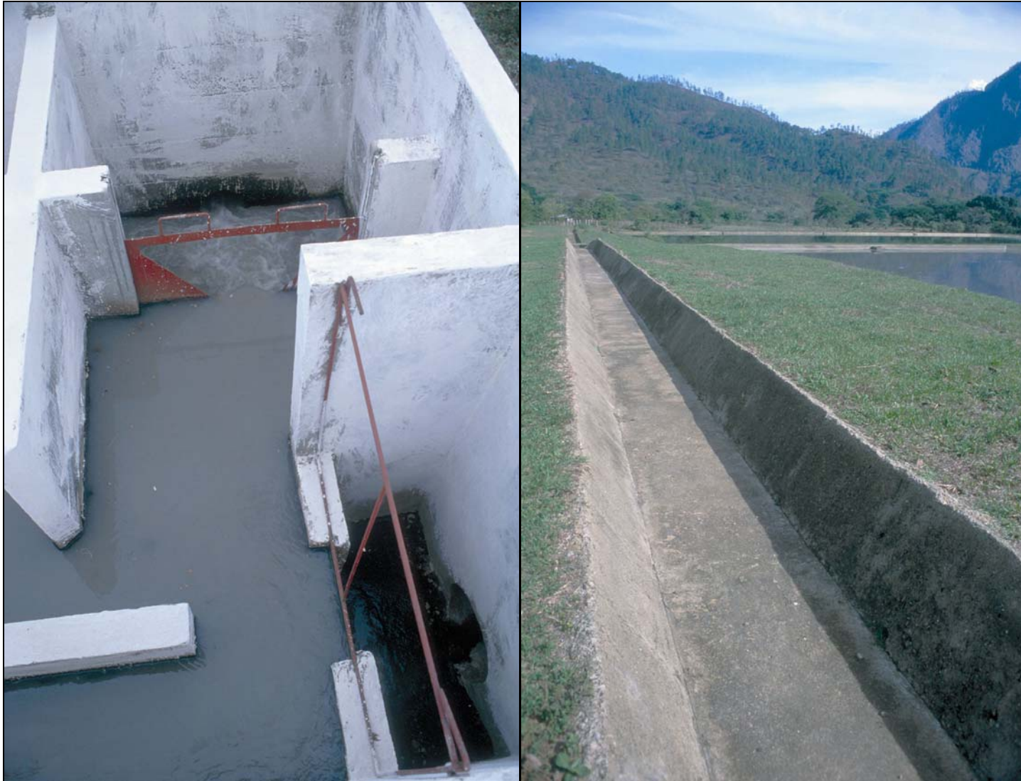
Fotos 6-17: Ejemplos de vertederos de demasías y canales de desvío para proteger el sistema de lagunas de sobrecargas durante tormentas. El vertedero a la izquierda es ajustable y el operador puede ajustarlo cuando sea necesario. Cuando el nivel de agua sube durante un caudal excesivo, un porcentaje del caudal es descargado al canal de desvío. (Foto izquierda: Granada, Nicaragua. Foto derecha: Danlí, Honduras)
