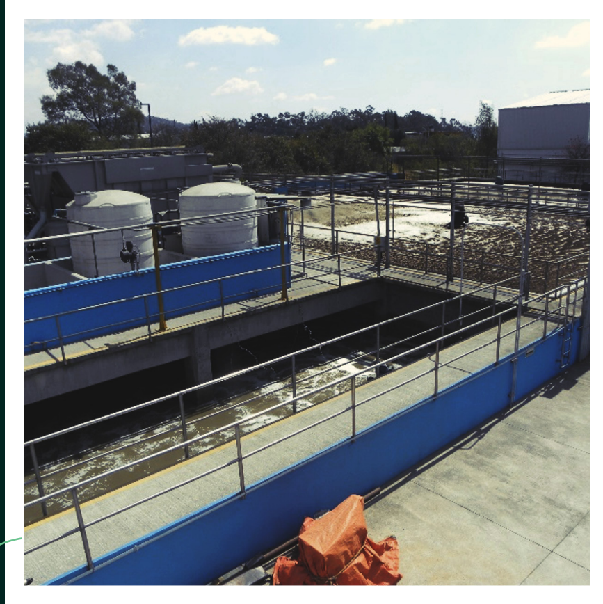
FIGURA 5.8 SISTEMA DE LODOS ACTIVADOS (FUENTE: II-UNAM)
