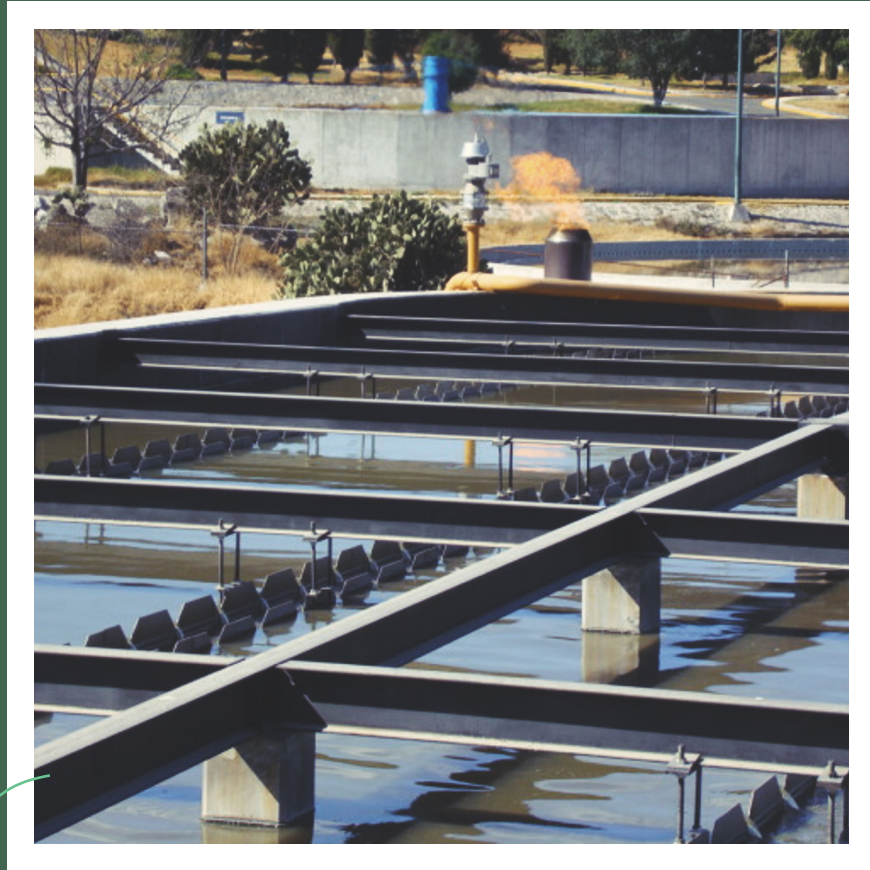
FIGURA 3.3 SISTEMA ANAEROBIO PARA TRATAMIENTO DE AGUAS RESIDUALES MUNICIPALES CON QUEMADO DE BIOGÁS (FUENTE: II-UNAM)
