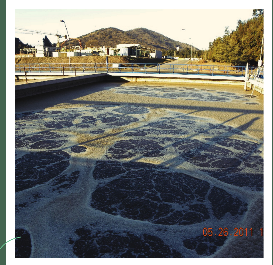
FIGURA 3.2 SISTEMA DE LODOS ACTIVADOS (FUENTE: IBTECH)
